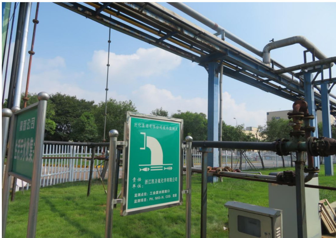
污水排放口近照
