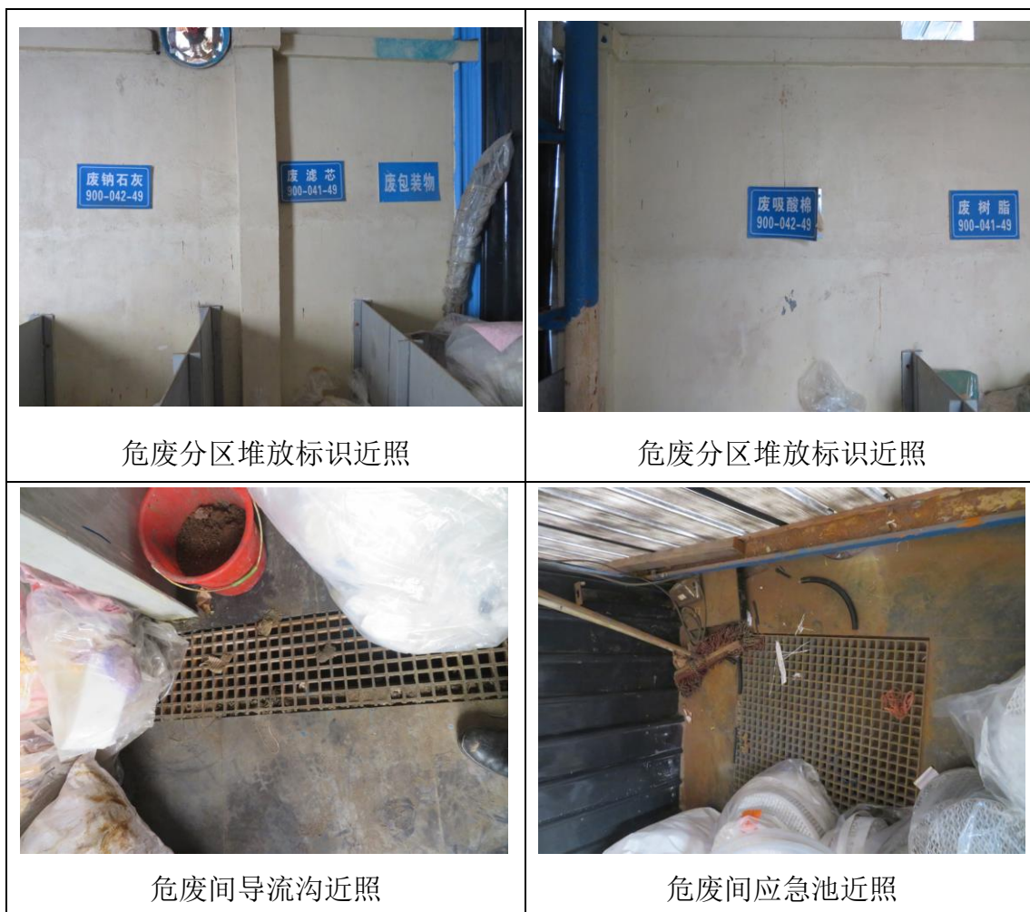
图 4.1-4 危废贮存场所照片
