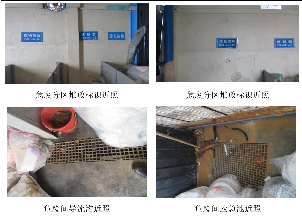
图 4.1-6 危废贮存场所照片
