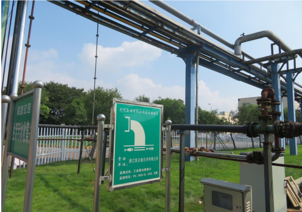
污水排放口近照
