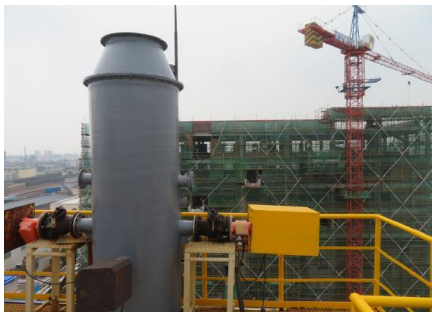
3#排气筒近照（30m 高）
