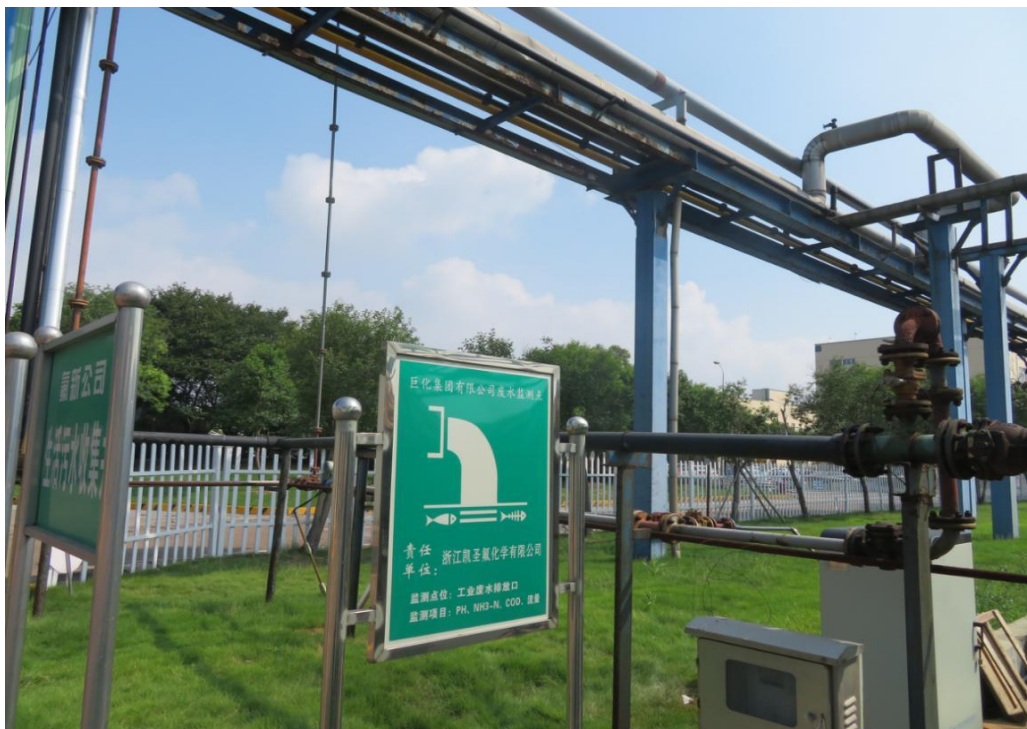
污水排放口近照
